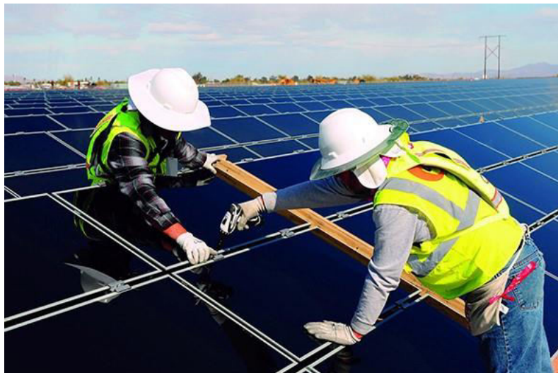
Dự án lắp đặt pin năng lượng mặt trời tại Bình Thuận
